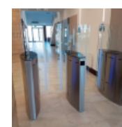
Kontrola ruchu pieszych
